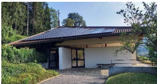
Technische Angaben der Anlage Generatorleistung: 68,89 kWp 3 Wechselrichter,
